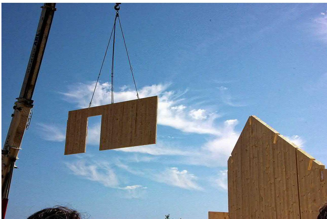
Cette structure en bois ayant été fabriquée en usine, sa pose (par une grue) était particulièrement spectaculaire. La construction bénéficie du label H.Q.E. Le chantier se situe "Chemin d'une ruelle à l'autre" (à 100 m derrière le cimetière d'Ennery) et une visite récente a permis de mesurer la rapidité de la construction permise par la technique employée.
